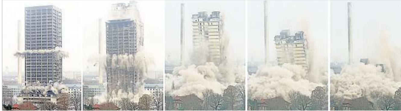
900 Kilogramm Sprengstoff bringen den Uni-Turm innerhalb weniger Sekunden zum Einsturz. Mit 116 Metern Höhe war der von Werner und Nitschke geplante „Afe-Turm“ das höchste bislang gesprengte Haus in Europa. Tausende schauten im Februar zu und ließen Sektorkorken knallen, als das hässliche Gebäude fiel, einige trauerten ein wenig. Foto: dpa
